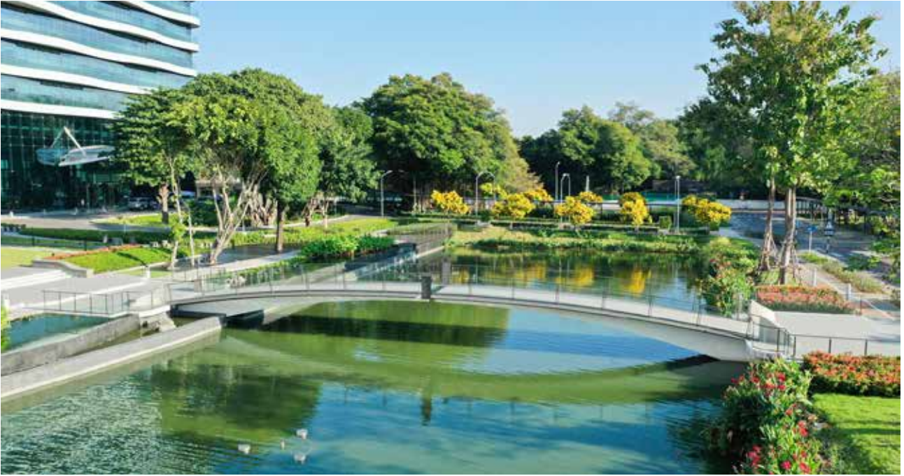
CPAC Ultra Bridge Solution วัตกรรมสะพานคอนกรีตผสมตะปูนสูงที่บางที่สุดแห่งแรก ในประเทศไทยและอาเซียน ด้วยเทคโนโลยี UHPC (Ultra high Performance Concrete)
